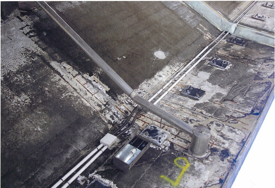
FOTO 6 - Dettaglio del degrado in prossimità della caditoia sulla pila 16 (interno curva)
