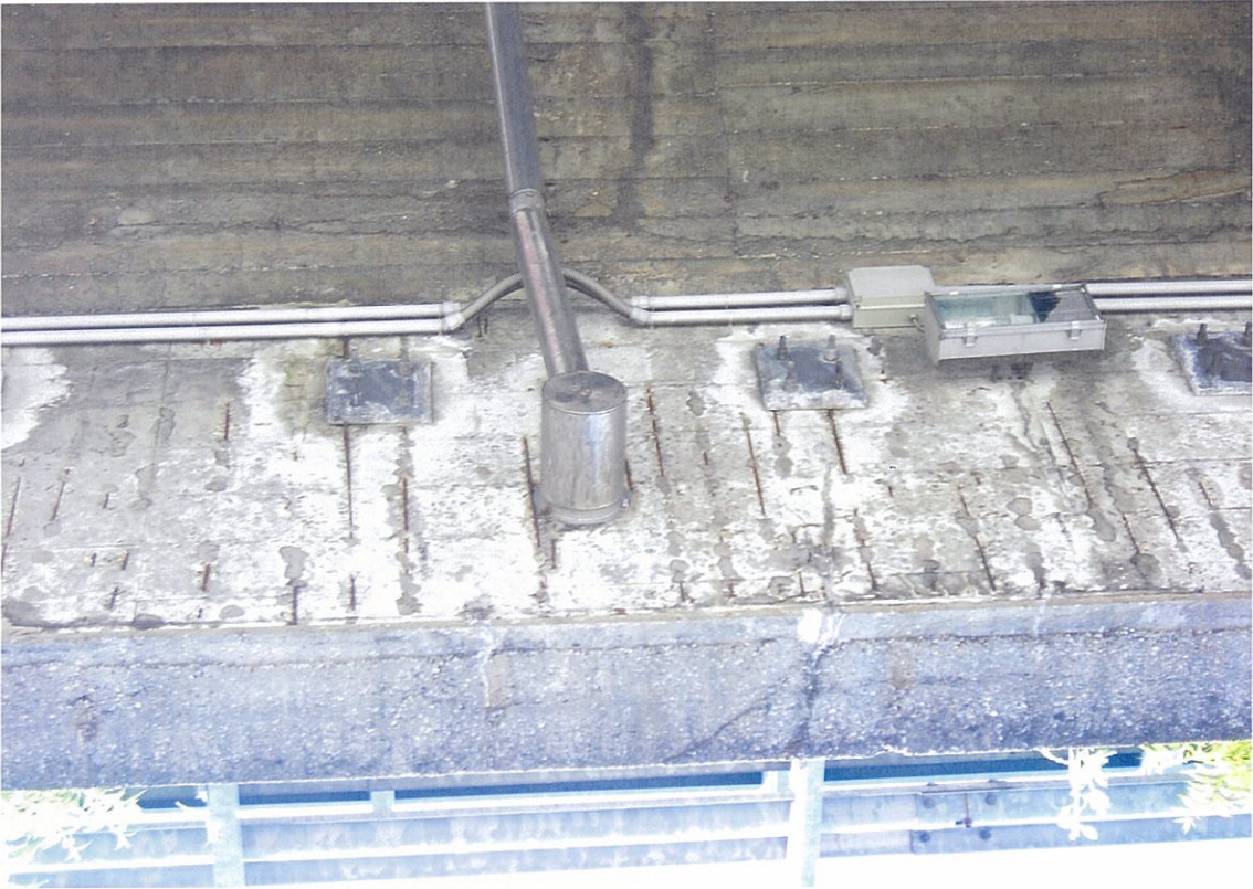
FOTO 6 - Dettaglio del degrado in prossimità della caditoia sulla pila 16 (interno curva)
